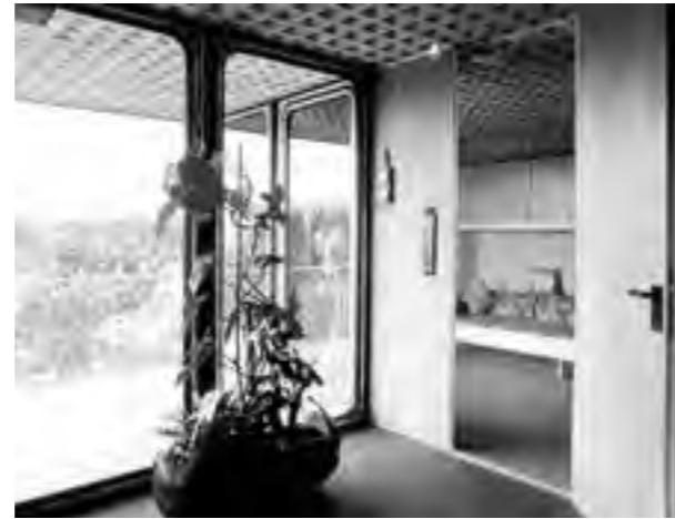
Eine Besonderheit stellte im Habiflex der „Gelsenkirchener Balkon“ dar. Ein bewegliches Fensterelement ermöglichte es, den Wohnraum um die Balkonfläche zu erweitern.
