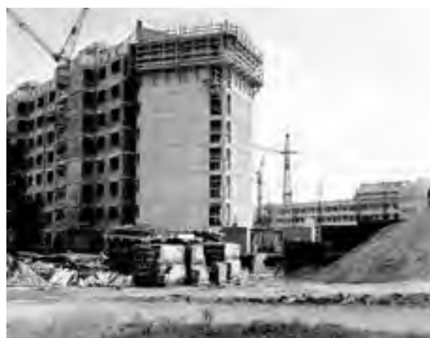
Die Aufnahmen zeigen die nach ihrem Architekten benannte Baugruppe Marschall im Bau. Im Bild rechts erkennt man bereits den „Handwerkshof“, der die ersten Läden aufnahm.
