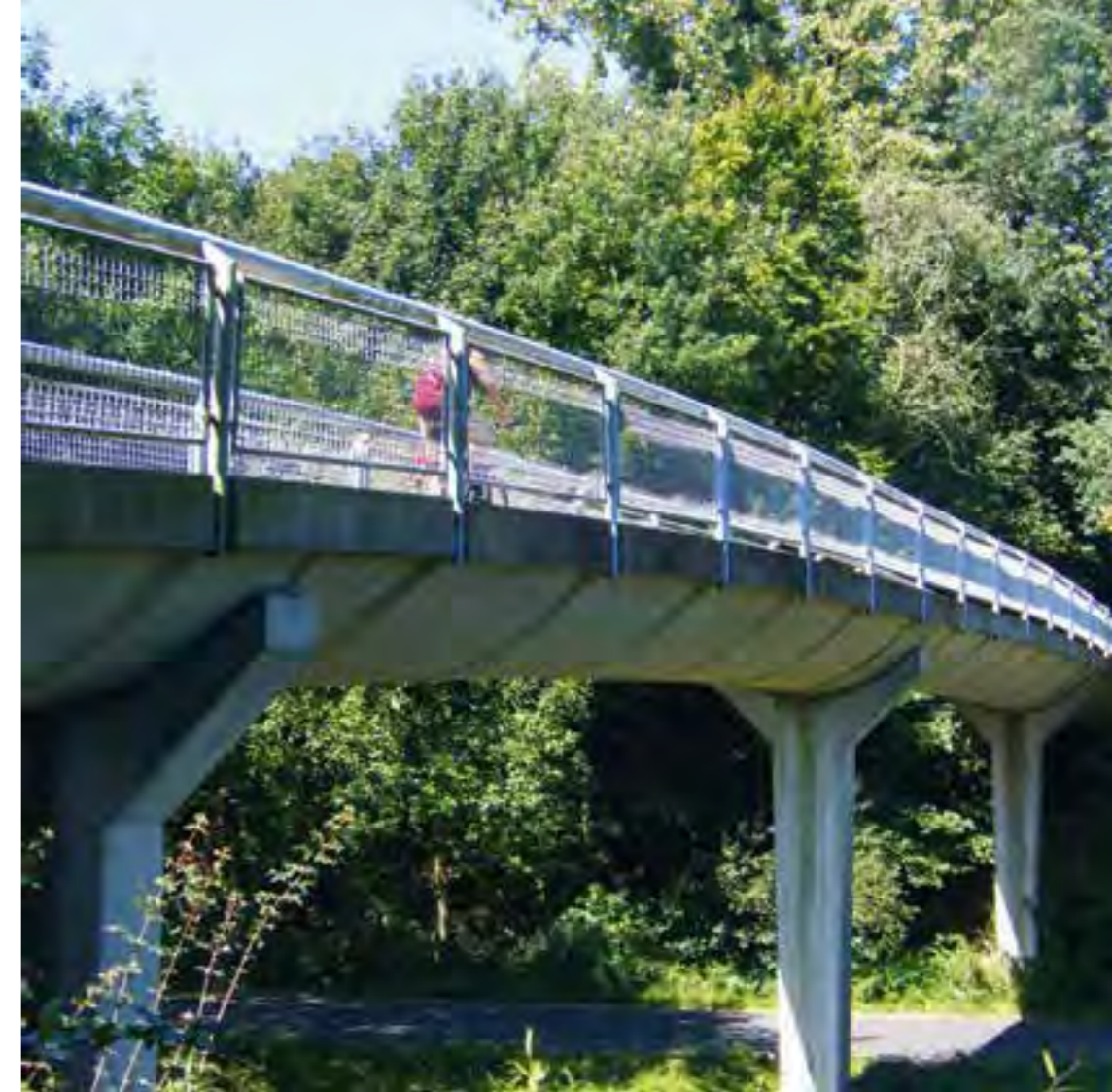
Brücke des Napoleonsweges über den Wittenberger Damm
